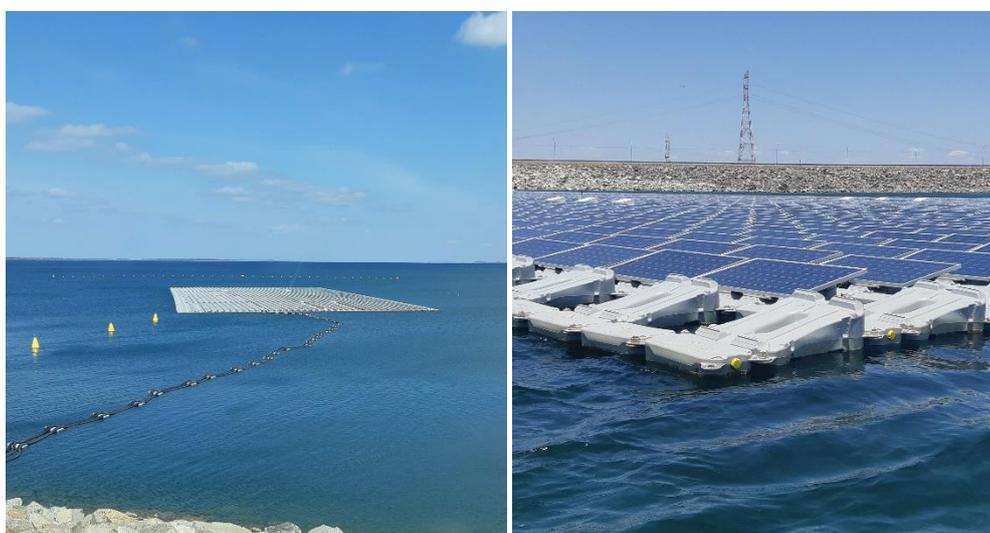
**Figura 18 - Usina solar fotovoltaica flutuante no reservatório da UHE Sobradinho**
